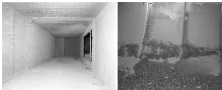
Fot. 1. Kurz osiadły na ściankach kanału i większe zanieczyszczenia w postaci ziarniste [1]
